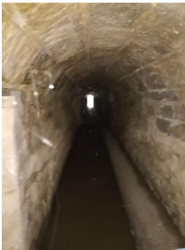
Figure 17. Ouvrage maçonné exutoire du réseau EP – secteur Aristide Briand
