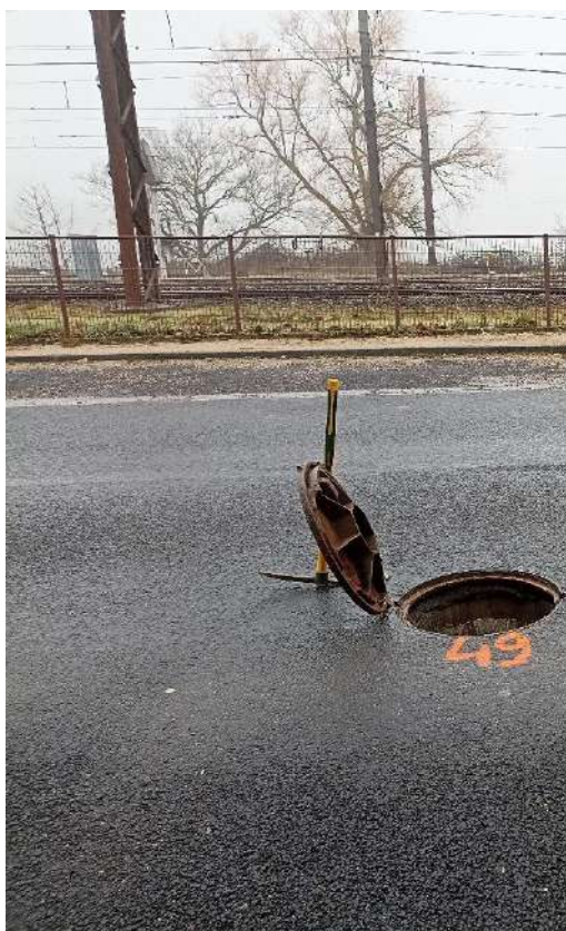
Figure 16. Regard de l'exutoire du réseau EP – Avenue Aristide Briand
