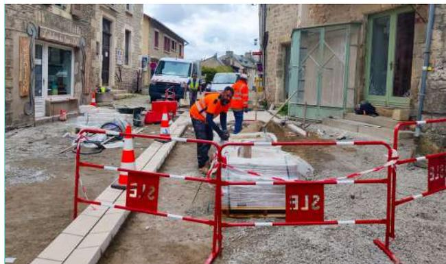
À la suite de l'enfouissement des réseaux secs et humides, les entreprises chargées de la réfection des rues du Grand Faubourg et Auguste Girou ont été sélectionnées. Les travaux d'aménagement des chaussées et trottoirs, réalisés par l'entreprise SLE de Mende sous la maîtrise d'œuvre de Frayssinet Conseil et Assistance, ont débuté en janvier 2025.
