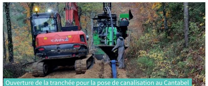
Ouverture de la tranchée pour la pose de canalisation au Cantabel
