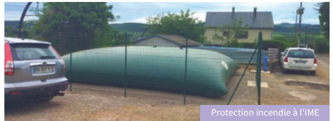
Protection incendie à l'IME
