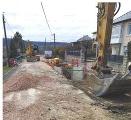
La réfection des réseaux des eaux pluviales et des eaux usées se poursuit sur l'Avenue du Général de Gaulle. La route reste barrée vers l'ancienne gendarmerie en raison de la profondeur des tranchées. Il est rappelé aux riverains qu'ils sont dans l'obligation de faire les séparatifs eaux usées/eaux pluviales sur
