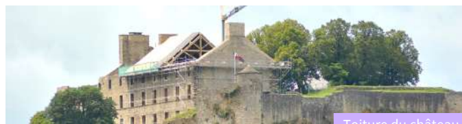
Toiture du château
